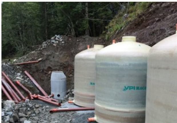
Fra etableringen av renseanlegget på Hjortland.
