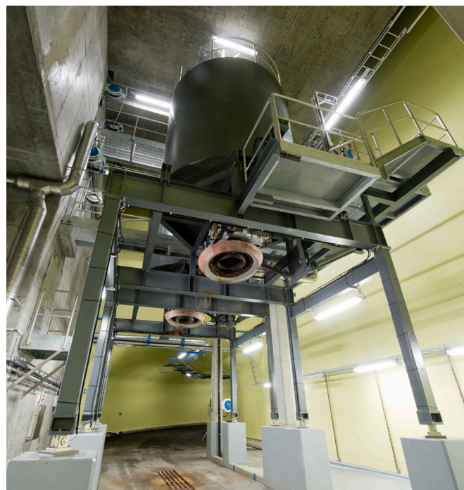
Når avløpsvannet er ferdig rensed har vi et sluttprodukt som kalles slam. Slammet samles i tankene før det transporteres til biogassanlegget for produksjon av drivstoff til byens busser. (Foto, Helge Skodvin)
