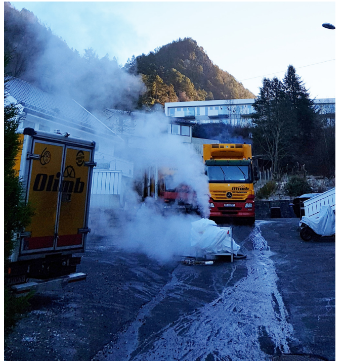
Vann- og avløpsetaten tilstreber å benytte NoDig-metode mest mulig ved fornying av avløpsnett. Her er det herding av strømpen som pågår. (Foto, Gunn Eklund Breisnes)
