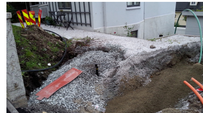
Fornyng og tilknytning av privat nett i forbindelse med opparbeiding av Ibsens gate. (Foto, Einar Høgmo)
