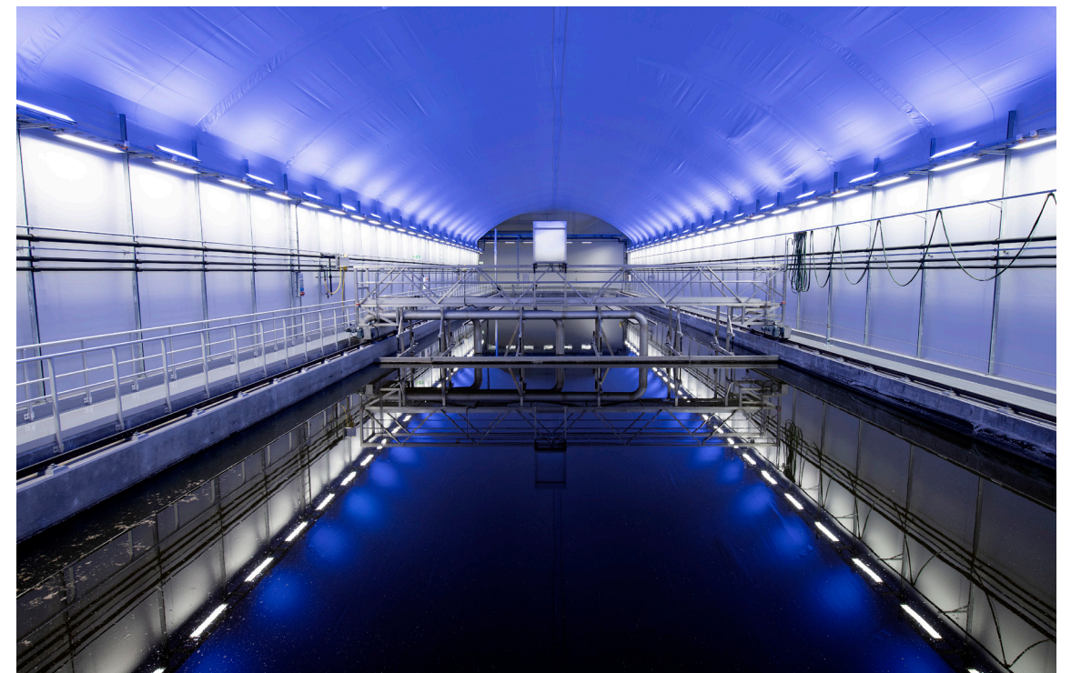
Sedimenteringsbasseng ved Flesland avløpsrenseanlegg som ble åpnet i 2017. (Foto, Helge Skodvin)
