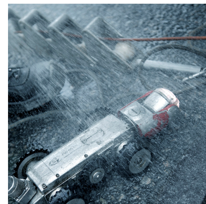
For å undersøke rørenes tilstand benyttes det kamera. (Foto, Helge Skodvin)
